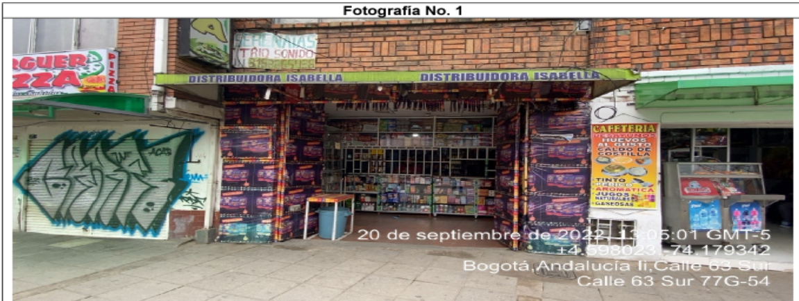
En la cual se evidencia la fachada del establecimiento comercial DISTRIBUIDORA ISABELLA , en la CL 63 sur No. 77 G – 54 de la localidad de Bosa.
